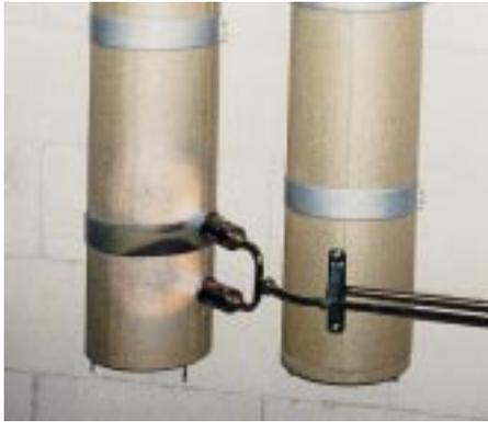
**Das Rohr erreicht eine Feuerwiderstandsdauer von 90 Minuten**
