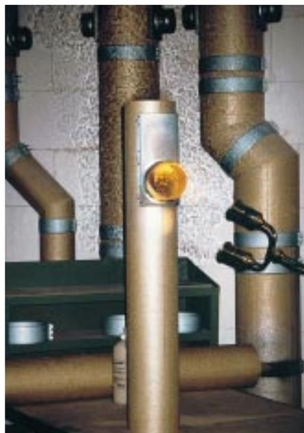
**Das Brandschott des Aerotec-Anschlusses: Wenn's brennt, fällt die Klappe**
