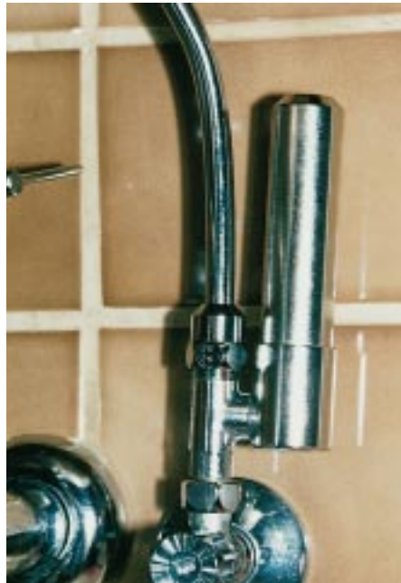
Der unter dem Waschtisch am Eckventil montierte etwa 120 mm hohe Druckschlagdämpfer wirkt kaum störend
