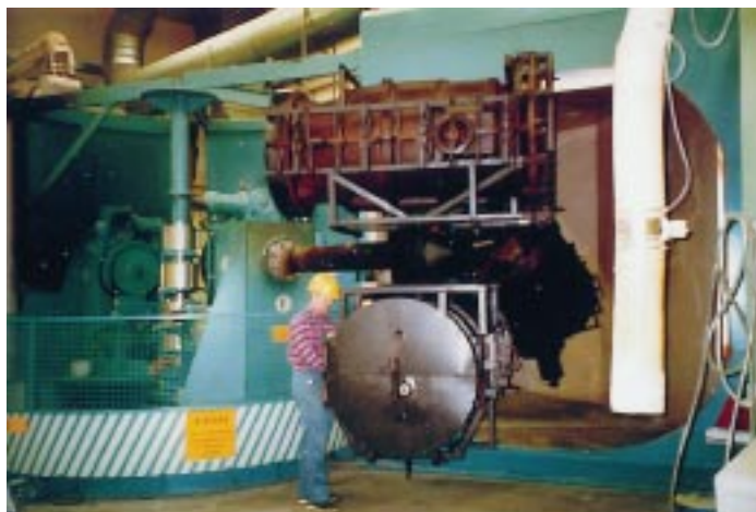
Durch die 3-Kammer-Rotations-Sinteranlage kann die ausgefallenste Form produziert werden
