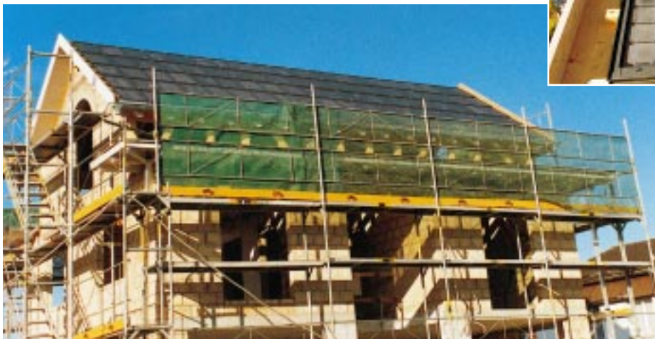
Etwa 45 m 2 Solar-Dachfläche decken den Bedarf eines Einfamilienhauses an elektrischem Strom
