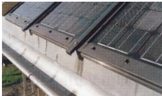
Der Traufanschluß der Solarelemente zeigt deren Befestigung mit Abdeckprofilen zum Abdichten des Daches
