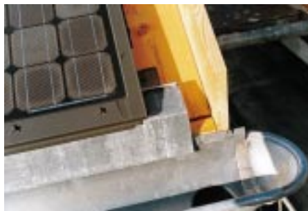
Anschlußdetail der Solar-Dachziegel-Verlegung vor dem Verahren des Ortgangs
