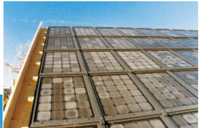
Etwa 45 m 2 Solar-Dachfläche decken den Bedarf eines Einfamilienhauses an elektrischem Strom
