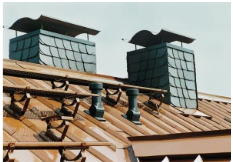
... wie Leiterhaken (r.), Stützen für Laufstege, Steigritte und mit einem Einbau-rahmen versehene Dunstrohre für die Nennweite DN 100
