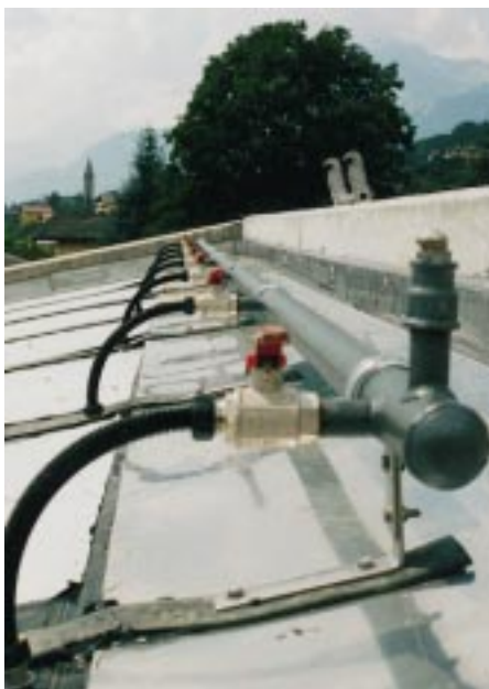
. . . und über Kugelhähne an den Sammler am First angeschlossen. Dessen Halter werden über das verlängerte EPDM-Profil auf dem Dach befestigt [4]
