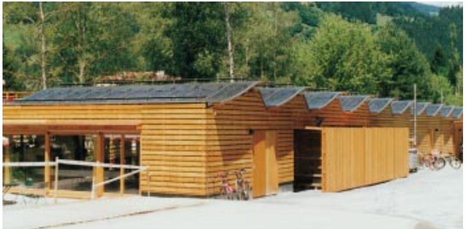
Die vor über 15 Jahren entwickelten Kollektoren werden seit kurzem auch in Deutschland eingebaut [4]
