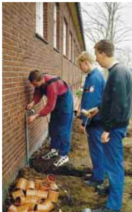
Letzte Handgriffe: Reinigen des Außen-Zapfventils von Hanfresten
