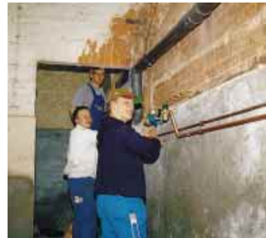
... während die dritte Gruppe die Trinkwasser-Nachspeise-Leitung installierte
