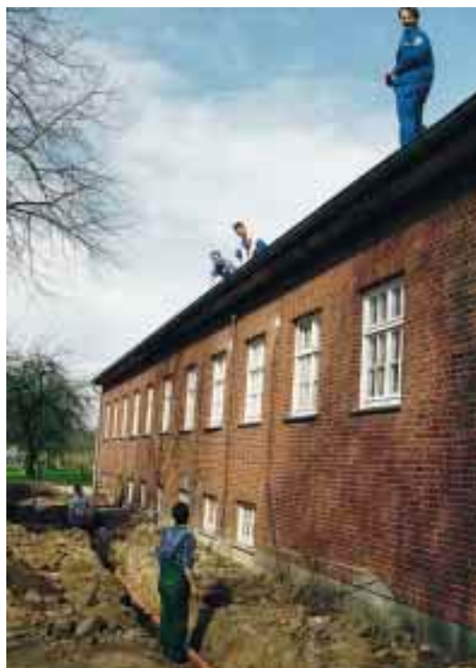
Eine weitere Gruppe verlegte die Kunststoffleitung, die zur Zisterne führt ...
