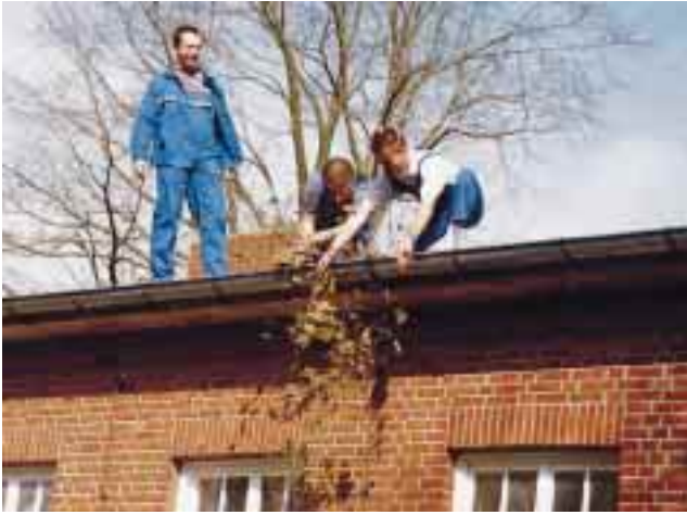
Bevor man sich der Regenwassersammlung widmete, wurde die Dachrinne gründlich gereinigt
