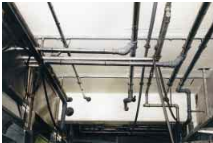
Tragschalen erlaubten Befestigungsabstände zwischen 1,5 und 2 m
