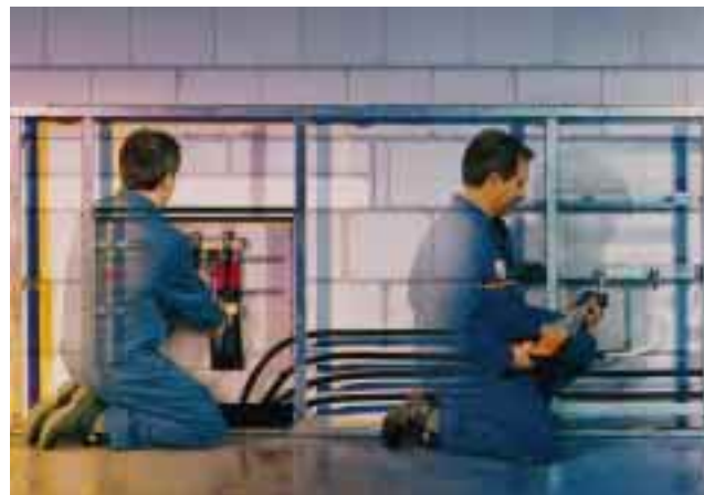
Durch die metallische Komponente bleibt das Verbundrohr formstabil; außerdem wird die Längenausdehnung reduziert
