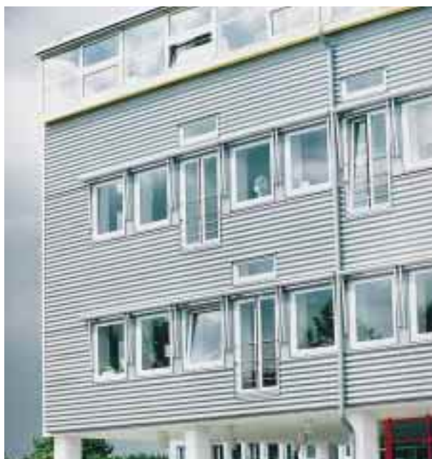
Große Bereiche der Fassaden an den Verwaltungsbauten der T-Mobil sind mit horizontal angeordneten Wellprofilen bekleidet
