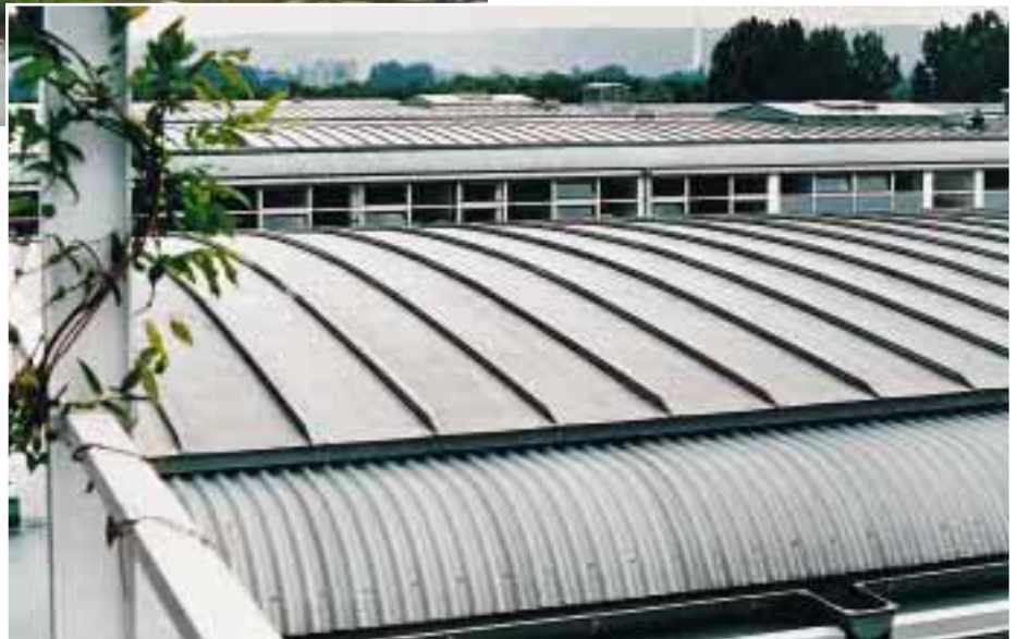
Die Segmentbogendächer sind im sogenannten Klick-Leistensystem gedeckt, während die viertelelliptisch gewölbten Traufübergänge aus Wellprofilen bestehen
