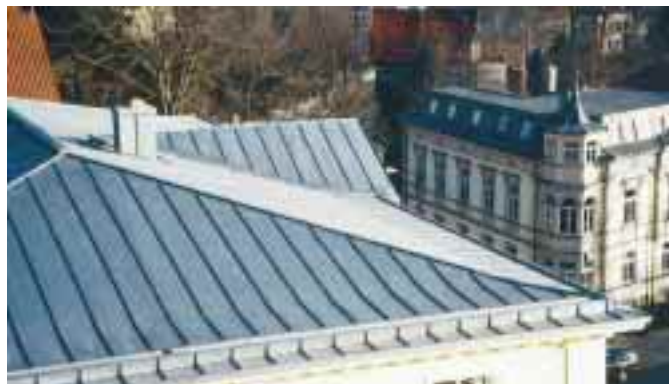
Bei der Neugestaltung des Daches der ehemals „Kramerschen Villa“ wurde die Traufkante mittels Schieblingen höhergelegt
