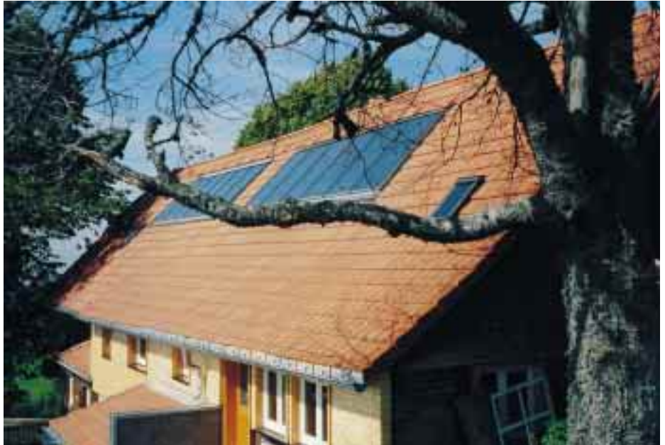
Kombinierte Solar-Luft- und Photovoltaik-Kollektor-Anlage, die z. B. die Sanitärräume der Hütte des Deutschen Alpenvereins, Sektion Freiburg, weitgehend frostfrei hält
