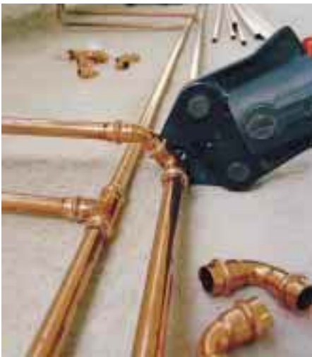
Verpressen der Kupferrohre und -fittings
