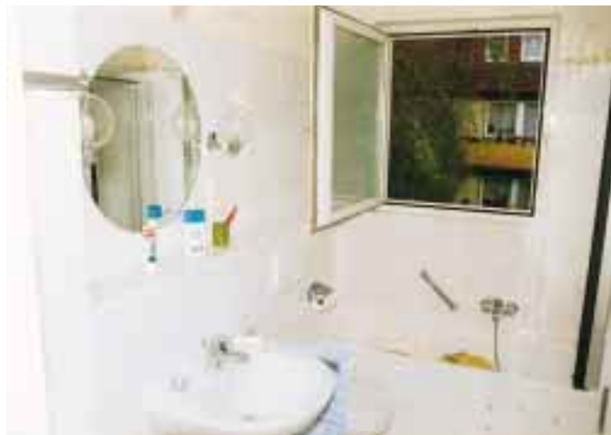
Zehn Tage brauchten die Installateure für die Modernisierung der 22 Bäder, die nun freundlicher und großzügiger wirken
