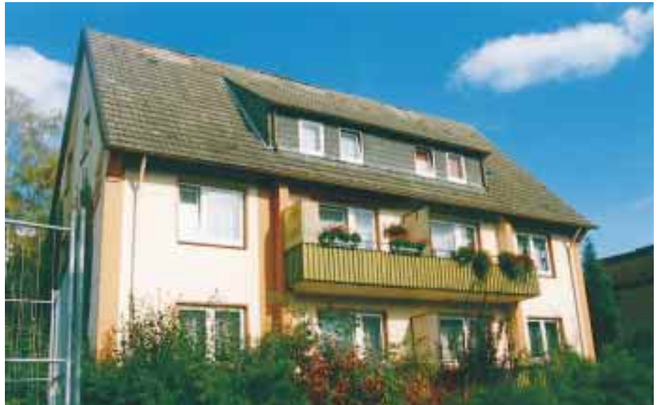
Die Häuser der Siedlung „Elsfleth-Unterweser“ stammen aus dem Jahre 1954 und standen zur Modernisierung an
