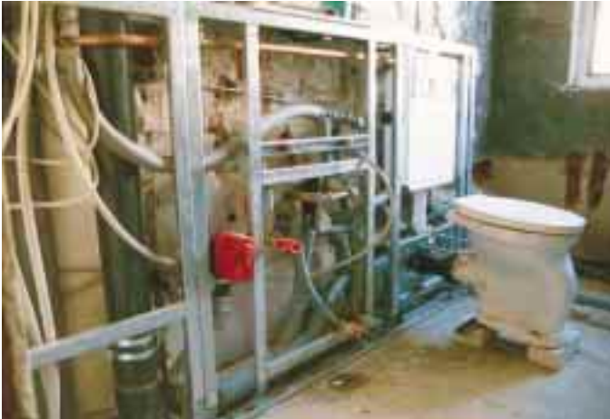
Gleichzeitig wurden stets drei Bäder renoviert, wobei ein Not-WC auch während der Modernisierungsarbeiten benutzbar war
