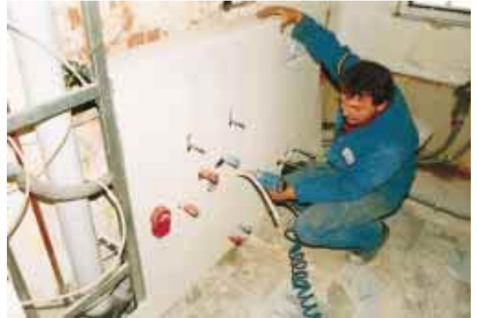
Mit dem Speedtacker konnten die vorgelochten Fermacell-Platten in 90 Minuten an den Varimont-AS-Gestellen befestigt werden
