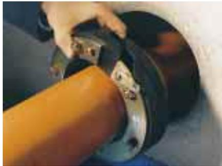
Der Einsatz ist bis zu einem Rohraußendurchmesser von 490 mm erhältlich und sowohl in galvanisch verzinktem Stahl wie auch in Edelstahl lieferbar. Bei der Gummidichtung stehen verschiedene Materialien zur Auswahl, die auch bei besonderen Anforderungen Lösungen bieten, z. B. wenn Temperatur-Beständigkeit von -90 bis +250 °C, spezielle Gasdichtigkeit oder Trinkwassereignung mit KTW-Empfehlung gefordert ist.
