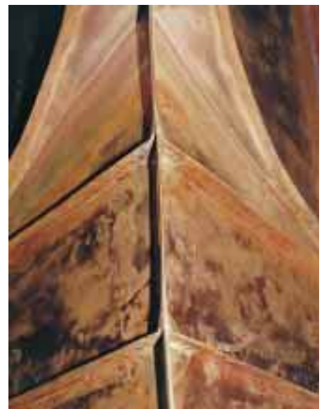
Im Firstbereich enden die Scharen in einem Doppelstehfalz
