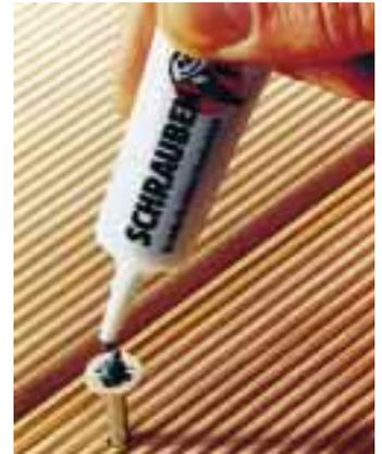
Druck mehrfach ansetzen und fertig ist der „Ersatzkopf“. Jetzt kann die Schraube problemlos ein- oder ausgeschraubt werden. „Schraubenfreund“ härtet in Sekunden an der Luft aus und ist extrem stabil und sicher, dabei ungiftig und ökologisch unbedenklich. Wer in Zukunft Ärger beim Arbeiten vermeiden will, sollte die kleine Tube immer in Reichweite haben.
