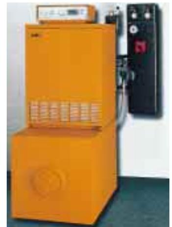
die Flammen von der Brenneroberfläche weg. Die Durchmischung und neue Edelstahl-Vormisch-Brennerlanzen ermöglichen niedrige NO<sub>x</sub>- und CO-Werte, die Anforderungen der neuen BImSchV sowie die verschärften Anforderungen des Blauen Engels erfüllen. Der NG-4E ist für Erdgas E, LL und für Flüssiggas geeignet. Durch das intermittierende Zündsystem ist ein störungsfreier Betrieb auch bei schwankender Gasqualität gewährt.
