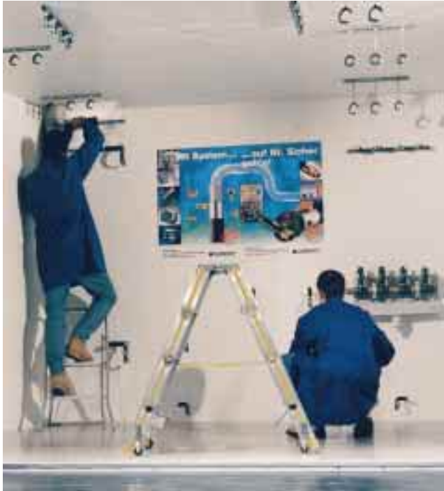
... während echte Installateure in der Mittagspause in einem „Wohnhaus auf der Bühne“ die Verlegung der GIS-Vorwandinstallation sowie der Rohrsysteme Mepla, dB 20 und Aerotech demonstrierten
