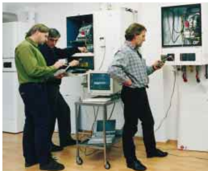
Heizungsbau-Meister informieren sich im Schäfer-Schulungszentrum Emsdetten intensiv über die Gas-Brennwertkessel
