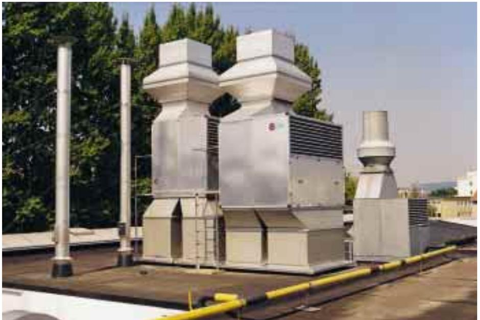
Mit Wärmerückgewinnungs-Anlagen läßt sich der Primärenergiebedarf in Handwerk und Gewerbe reduzieren, beispielsweise in Kfz-Werkstätten mit Lackiererei [3]
