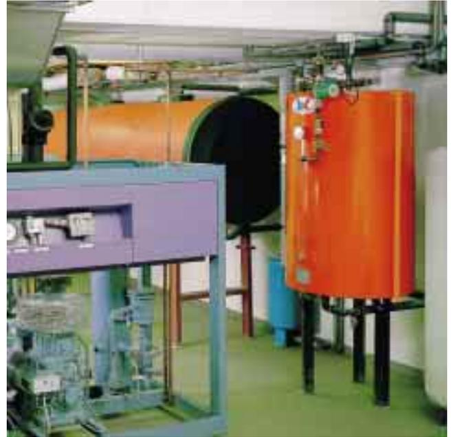
Wärmerückgewinnung im Verbund mit der Kälte-, Heiz- und Brauchwasseranlage eines Supermarktes, mit 1000-l-Heizwasserspeicher (liegend) und 300-l-Brauchwasserspeicher [2]
