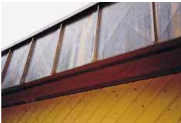
An jedem einzelnen Blechteil muß an allen vier Ecken eine Ausklinkung vorgenommen werden, ...
