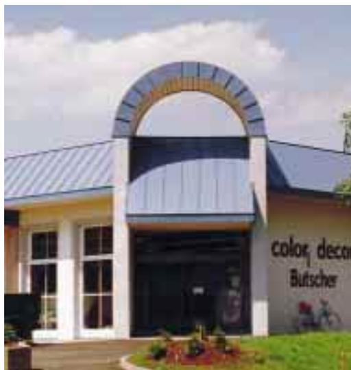
*Blende und Außenseite des freistehenden Bogens über dem Eingang zum Fachgeschäft wurde ebenso wie das Vordach mit kunststoffbeschichtetem Aluminiumblech bekleidet*
