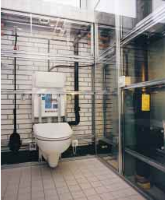
Um den Seminaristen die Praxisanwendung der Geberit-Produkte zu visualisieren, sind die VWI-Gestelle teilweise mit Acrylplatten beplankt
