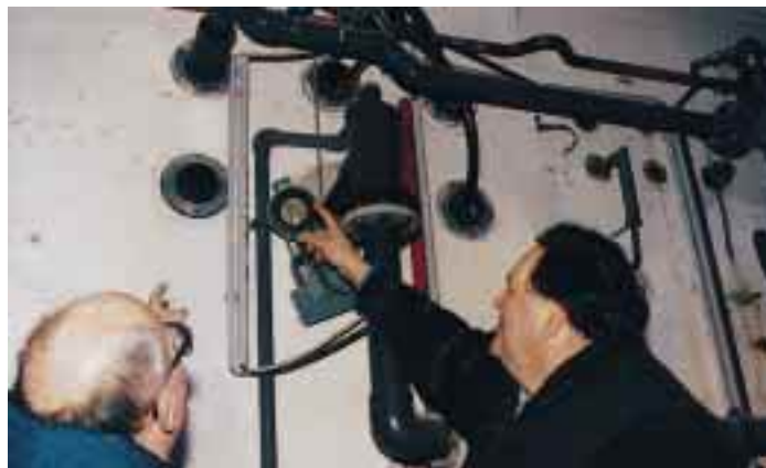
Auch nach über 25 Jahren in salzhaltiger Atmosphäre können viele der Dichtungen und Durchführungen weiterverwendet werden
