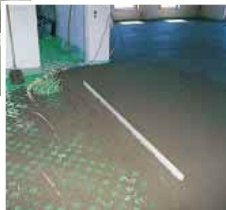
Für die Fußbodenheizung und -kühlung wurde das „VARI-P“-System verwendet, für dessen Verlegung zwei Tage benötigt wurden
