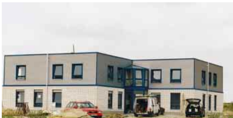
Das neue Büro- und Verwaltungsgebäude erhielt ein ansprechendes Äußeres mit dem weißen Kalksandstein, der grauen Aluminium-Verkleidung und den blauen Rahmen
