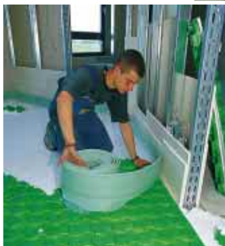
Für die Fußbodenheizung und -kühlung wurde das „VARI-P“-System verwendet, für dessen Verlegung zwei Tage benötigt wurden
