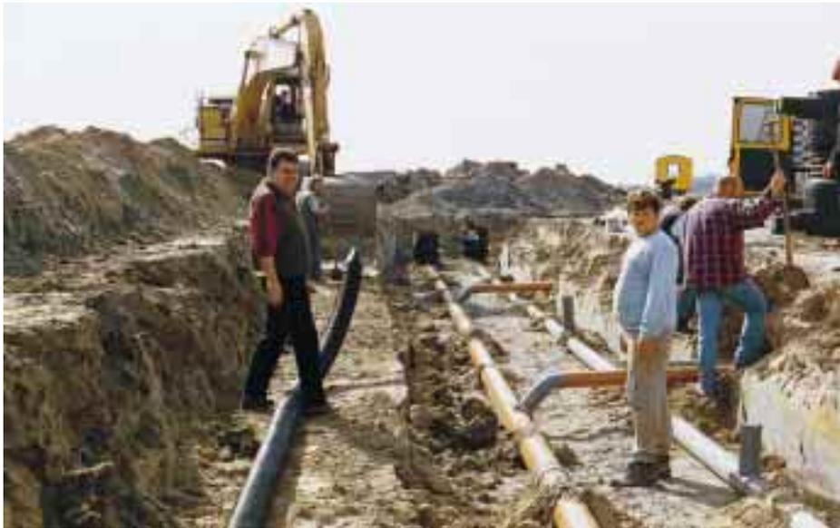
... Danach wird das vorkonfektionierte Ecoflexrohr verlegt und mit den Schächten verbunden
