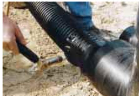
Die Abdichtung zwischen Schachtanschlußstutzen und Wellrohr erfolgt mittels eines Schrumpfschlauches
