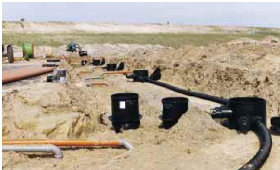
Nach dem Ausschachten der etwa 1 m tiefen Rohrgräben werden die Verteiler- und Inspektionsschächte positioniert...
