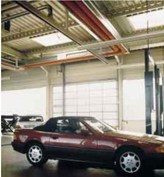
Dunkelstrahler „ETAline“ montiert in L-Form mit vollisolierten Blenden
