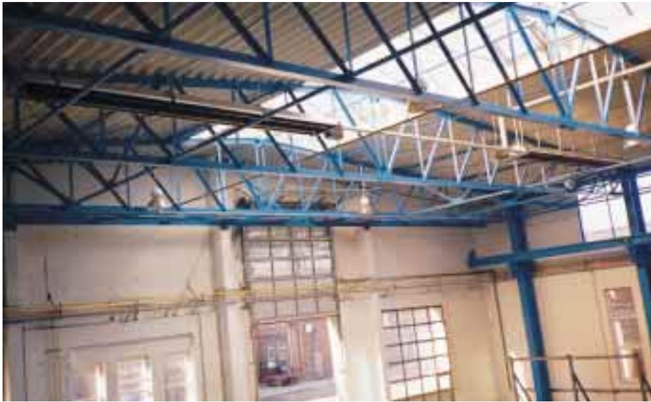
*Dunkelstrahler „ETAray“ montiert zwischen den Stahlbindern oberhalb der Kranbahn (Sammelabgasanlage)*
