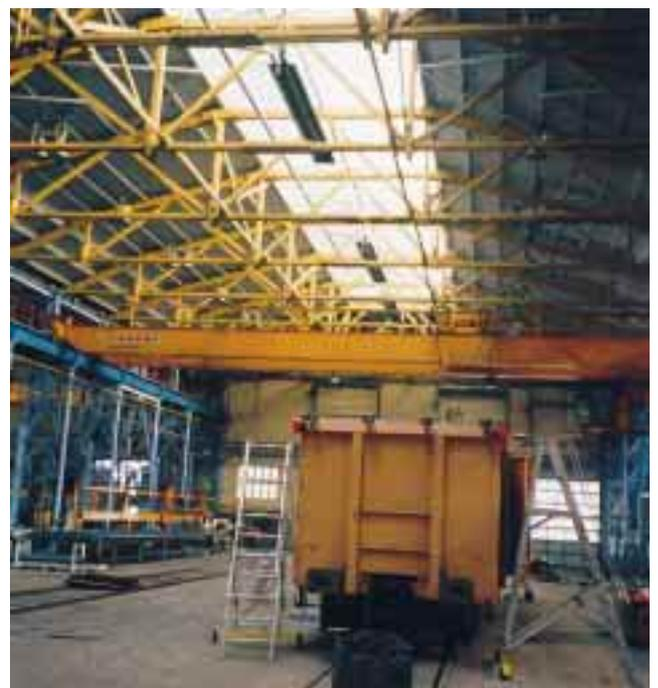
*Dunkelstrahler „ETAray“ montiert innerhalb der Fachwerkbinder oberhalb der Kranbahn (Montagehöhe: 13 m; Sammelabgasanlage)*
