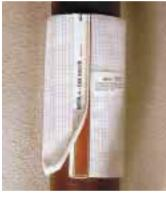
Mit der kombinierten Brandschutz- und Körperschall-Dämm-Manschette ist es möglich, bei gußeisernen Abwasserleitungen eine lückenlose Körperschall-Entkoppelung auch innerhalb feuerbeständiger Bauteile zu gewährleisten sowie der Entstehung eines Brandes und der Ausbreitung von Feuer und Rauch vorzubeugen.
