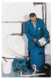
Das Mittel hat die DIN-DVGW-Reg.-Nr. 96.01e 1045. Es ist 2 Jahre lagerfähig und wird als 10-Liter-Gebinde geliefert. Das umfangreiche System-Zubehör wie Membranpumpe, Seitenkanalgebläse sowie Füllbehälter mit Entlüftungseimer garantieren wirtschaftliches und sauberes Arbeiten. Die kurze Trocknungszeit des Dichtungsmittels ist ein weiteres Plus.
