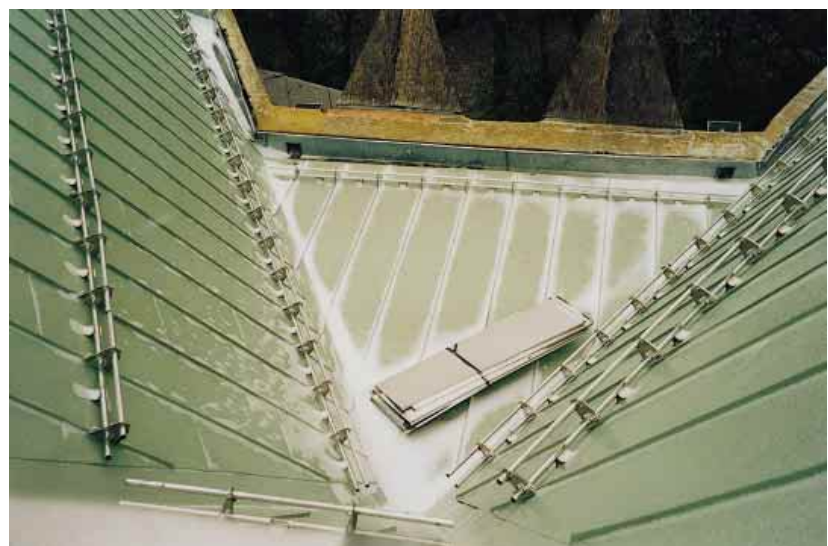
Nach dem Bekleiden des Hauptdaches mit Falzonscharen wurden Schneefänge montiert
