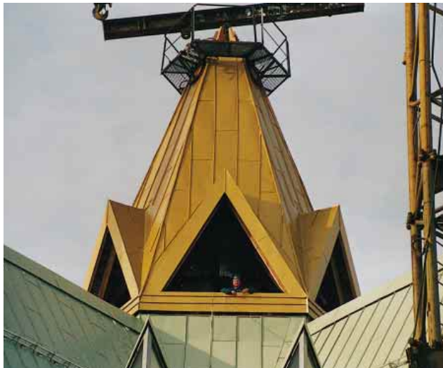
Zwei Kräne transportierten die fertig bekleidete Laterne an ihren endgültigen Bestimmungsort
