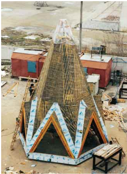
Die Laterne erhielt ihre komplette Bekleidung am Boden
