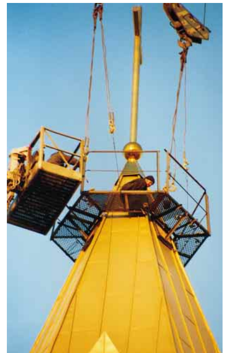
Zum Aufsetzen des Kreuzes war die Laterne mit einer provisorischen Arbeitsplattform ausgestattet worden
