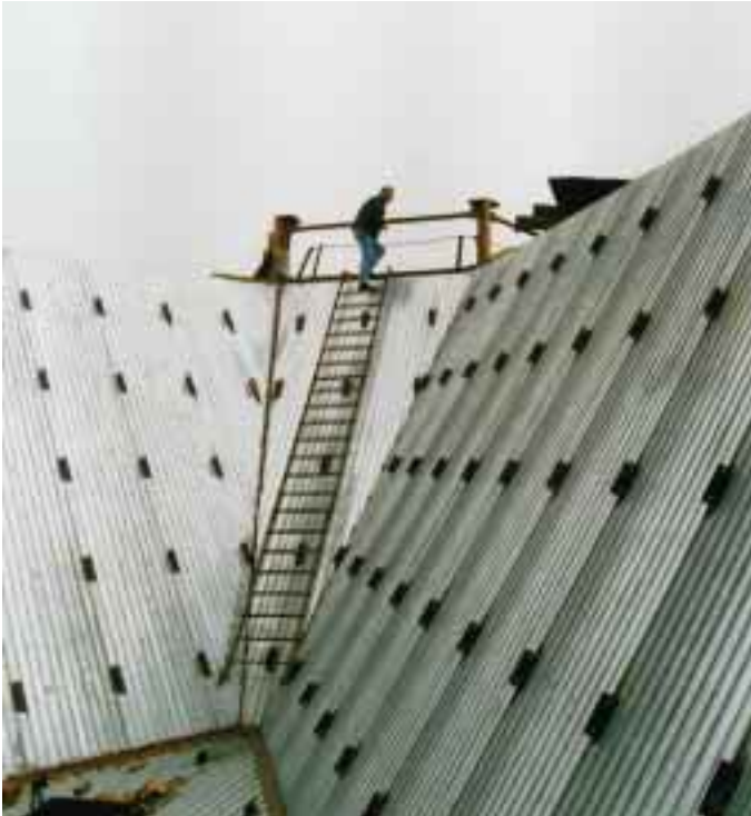
Die Dachunterkonstruktion besteht aus verzinkten Stahltrapezblechen, auf denen später Kanthölzer für die Dachschalung angebracht wurden
