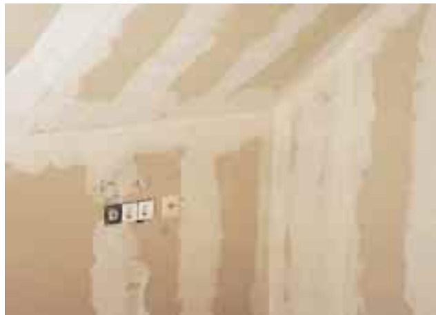
Bild 7 Abseiten/Giebelbereich eines Gebäudes
