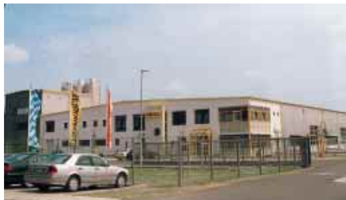
Das neue Werk von Fränkische in Schwarzheide. Ein funktionaler Bürotrakt ist der Fertigungseinrichtung angegliedert
