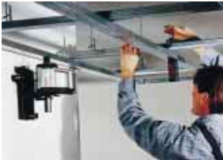
te für ein schnelles Finden der Strahlebene. In Innenräumen bietet die programmierbare Linienbetriebsart, bei der der Laser eine gut sichtbare Linie an die Wand projiziert. Der neue Rotationslaser eignet sich auch für den Einsatz am Boden, montiert auf einem Stativ oder einem Wandhalter. Mit dieser Lösung kann der Anwender waagerechte und senkrechte Linien, zum Beispiel für einen Meterriß leicht ermitteln. Im Innenbereich bietet die als Zubehör erhältliche Fernbedienung Nivellierkomfort.
