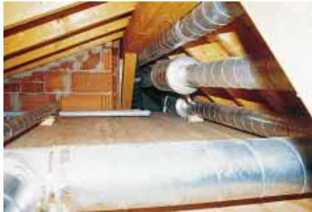
Wickelfalzrohr ist das strömungsgünstigste Material für das Kanalnetz
