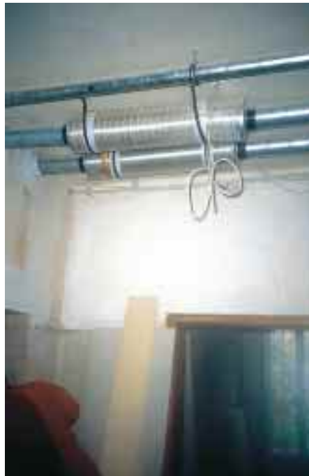
Bei VRG-Anlagen die Schalldämpfer hinter Ventilator und zwischen den Räumen nicht vergessen
