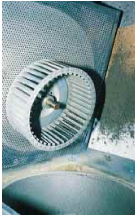
Lüfter-Räder sind regelmäßig zu reinigen
