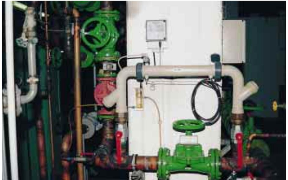
Installierte Anlage zur anodischen Oxidation . . .
