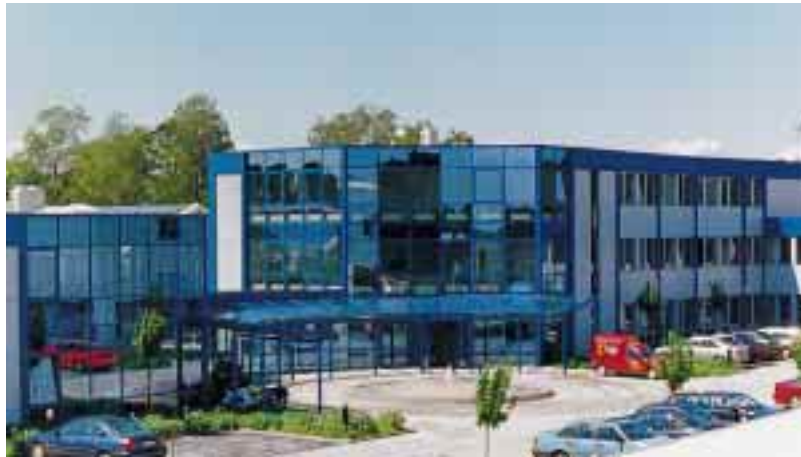
Im neuen Technikum der Grohe-Gruppe in Ludwigsfelde bei Berlin ist alles bereit für die gezielte Weiterbildung von Sanitärfachleuten
