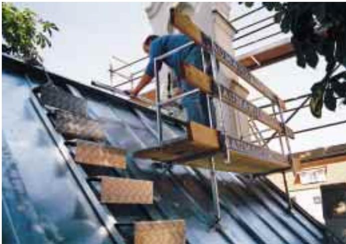
Dachneigungen von 45–60° eingesetzt werden. Die Ständer der Blechdachkonsole klemmt man mit einer Spannvorrichtung am Blechfalz fest.
