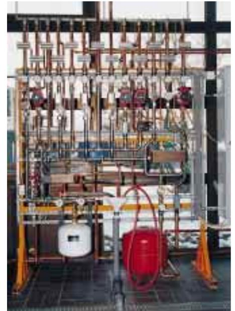
In der „Energiezentrale“ wird die Wärmeenergie der verschiedenen Wärmelieferanten gesammelt und an Verbraucher bzw. Speicher weitergeleitet
