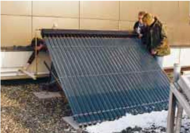
Mit Hilfe der Röhrenkollektoren wird soviel Sonnenenergie wie möglich „eingefangen“
