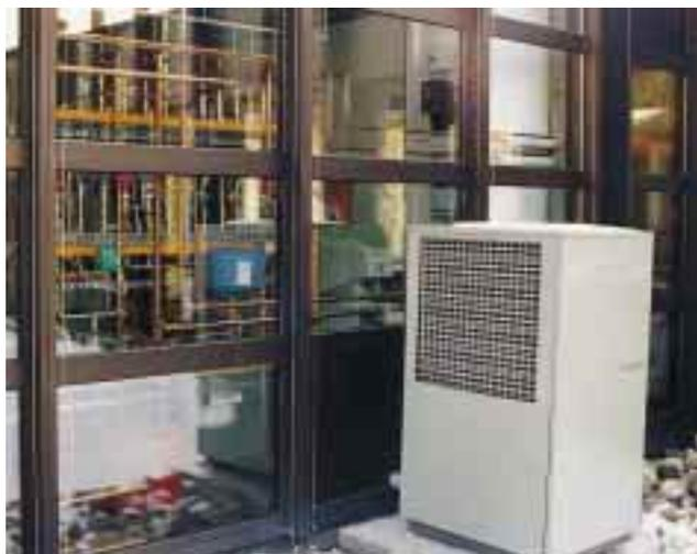
An zweiter Stelle als Wärmelieferant dient die Luft-Wasser-Wärmepumpe
