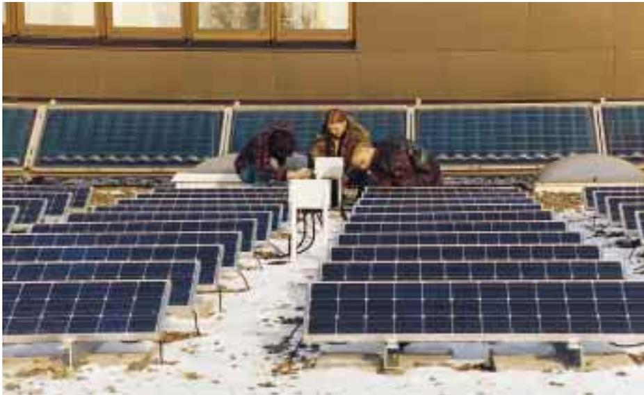
Die Photovoltaikanlage besteht aus 20 Modulen und ergibt eine Fläche von > 8 m<sup>2</sup> . . .
