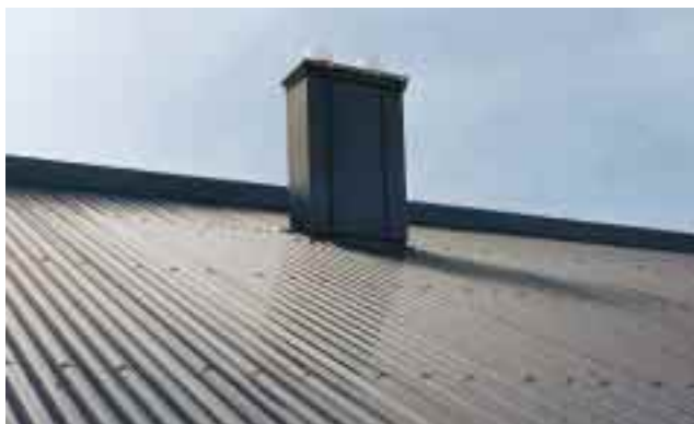
Die Schornsteinbekleidung ist im gleichen Farbton „Tiefblau“ gehalten wie die Profilbleche
