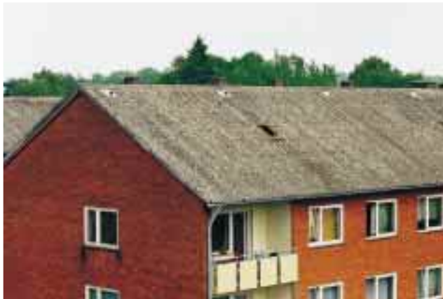
Die Dacheindeckung einer Wohnanlage in Münster aus asbestgebundenen Zementplatten . . .
