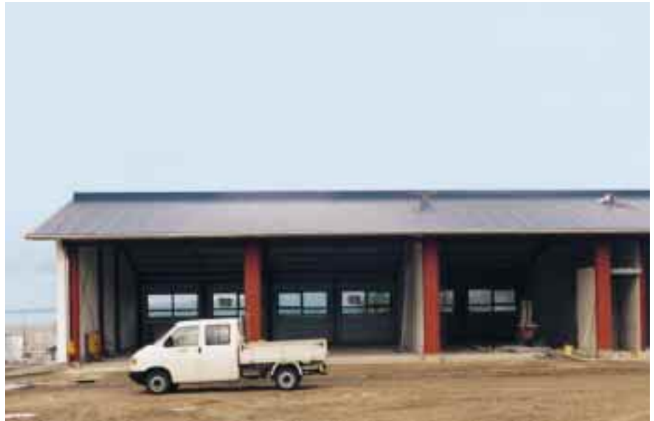
Die Gebäude des Gerätehofes in Dornstetten erhielten eine Dachbekleidung aus Aluminium-Trapezprofilen
