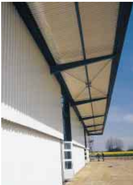
Während an einer Rostocker Lagerhalle für die Wände drei verschieden geformte Trapezprofile in der Farbe „Warmweiß“ verwendet wurden...
