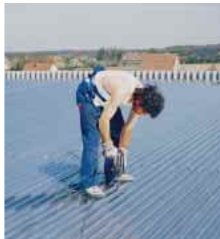
Überlappungen und Formteile werden mit selbstschneidenden und mit EPDM-Dichtungen versehenen Aluminium-Bohrschrauben befestigt
