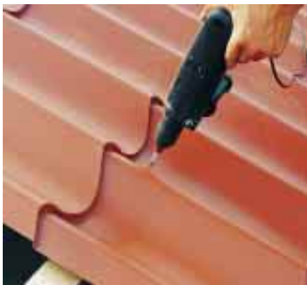
Die Profil-Elemente werden im Wellental des Profils mit selbstschneidenden und -dichtenden Schrauben an der Lattung befestigt
