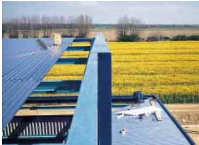
... erhielt das abgestufte Dach eine Bekleidung aus walzblanken Profilen in „Tiefblau“
