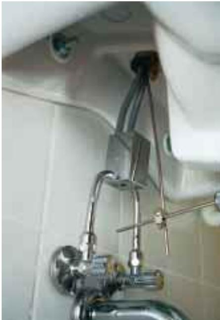
**Bild 3** Der Zirkulationsregler mißt  $40 \times 40 \times 66$  mm und ist so konstruiert, daß er sich auch dicht unterhalb der Mischbatterie im nicht sichtbaren Bereich des Waschbeckens einbauen läßt
