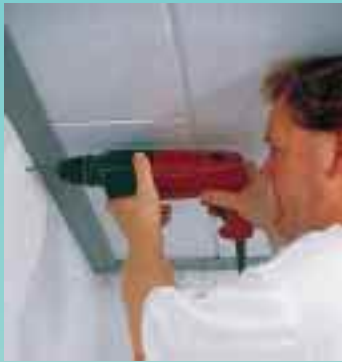
1 Bohrungen für Profil-Befestigung
