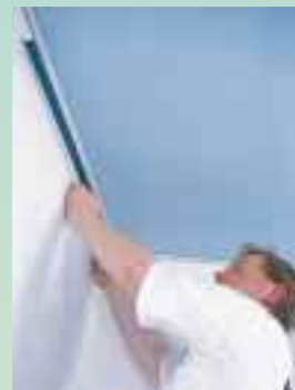
9 Befestigen des Zierprofils
