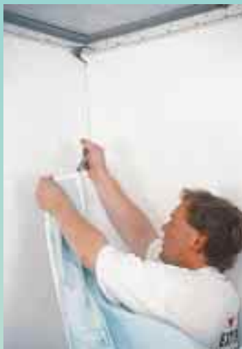
4 Nach dem Auspacken die Deckenfolie an Montageklammern hängen
