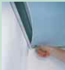
7 Einklicken der ersten Ecke ins Wandprofil
