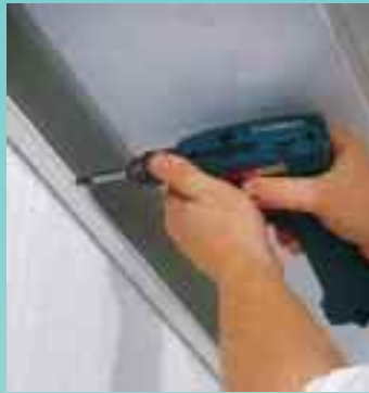
2 Befestigung des Wandprofils
