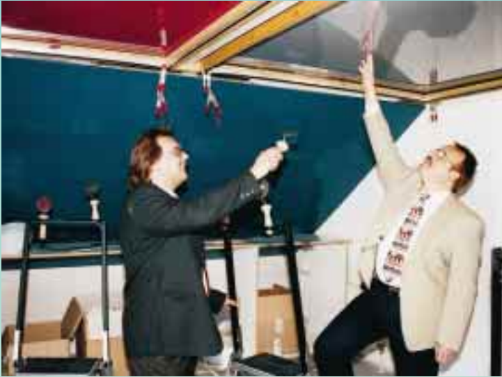
Thomas Kannengießer (l.) und Bernhard Müller sorgen mit ihren Spanndecken dafür, daß auch Sanitärinstallateure an die Decke gehen
