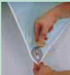
6 Ansetzen der Einsteckspachtel
