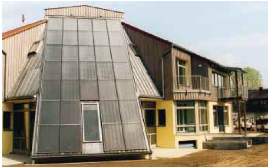
An der Südseite des ersten deutschen Null-Heizenergie-Hauses in konventioneller Bauweise dominiert das 50 m 2 große Kollektorfeld
