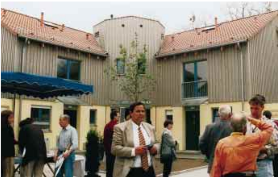
Das zweieinhalbgeschossige Gebäude wird hofseitig geprägt vom 10 m hohen Treppenturm, in dem der Speicher versteckt ist
