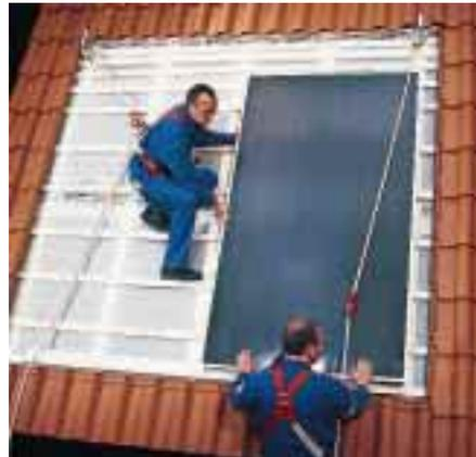
Flachkollektormodul mit 2,3 m<sup>2</sup> effektiver Fläche und mit 4 mm Solarsicherheitsglas (Vaillant)
