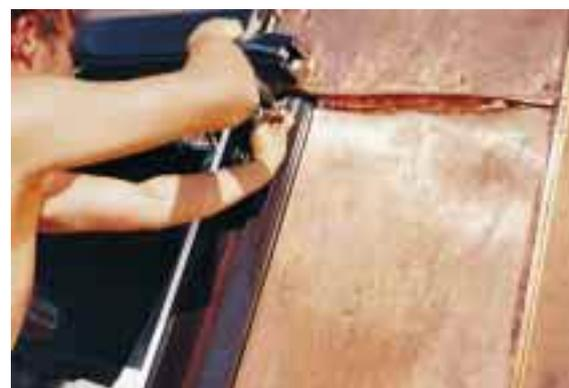
Nach dem Einbau des Dachfensters, dem Verlegen der seitlich anschließenden Blechscharen und dem Anbringen eines PVC-Unterlegteiles wird der Stoß mit einem Profil aus eloxiertem Alu abgedeckt
