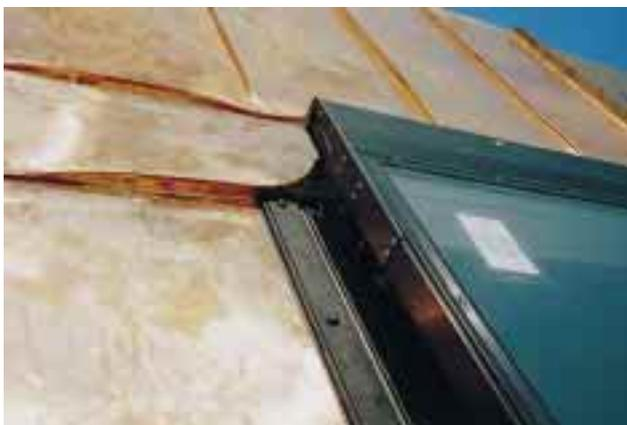
Das Verbindungsprofil mit der wasserdichten Endkappe stößt vor den hochgestellten Falz der über dem Fenster angeordneten Querschar
