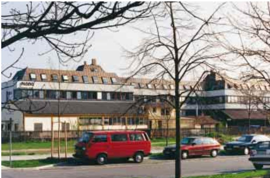
Bei dem Münchener Großobjekt wurden insgesamt 65 Fenster vom Typ Braas Atelier in die Stehfalzbekleidung des Mansardendaches integriert
