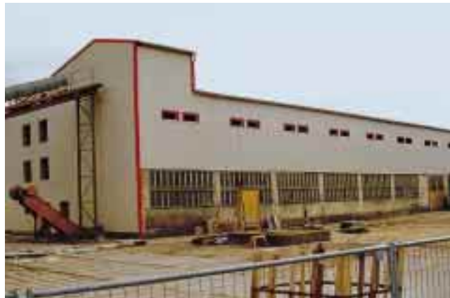
Nur noch der Bereich der Fenster erinnert an den inzwischen zum häßlichen DDR-Erbe mutierten Zweckbau in Brandenburg. Die restliche Wandbekleidung wurde mit Trapezblechen saniert
