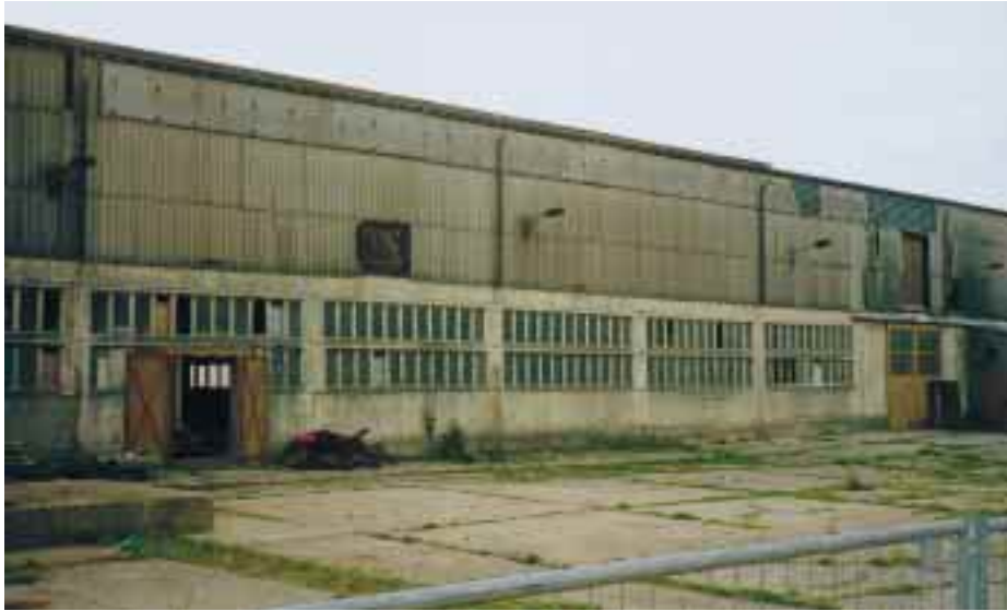
Nur noch der Bereich der Fenster erinnert an den inzwischen zum häßlichen DDR-Erbe mutierten Zweckbau in Brandenburg. Die restliche Wandbekleidung wurde mit Trapezblechen saniert
