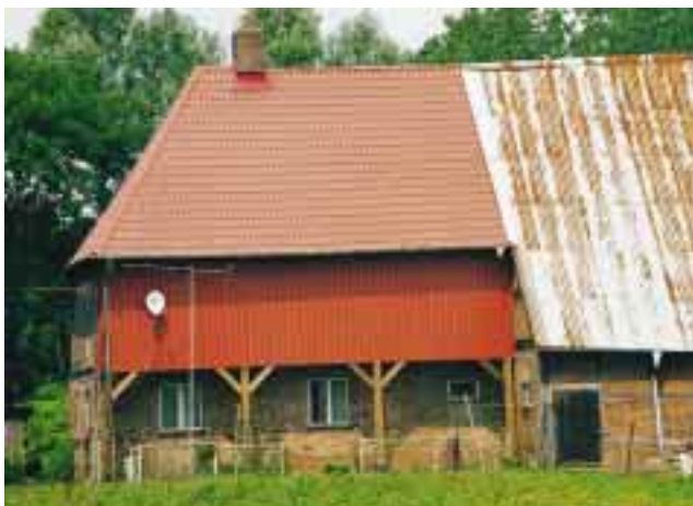
Der Wohnbereich dieses Bauernhauses in Mecklenburg-Vorpommern wurde mit Metalldachpfannen und Wandtrapezblechen saniert, während das Dach des Wirtschaftsbereiches noch mit Wellblechen aus der Vorkriegszeit bedeckt ist
