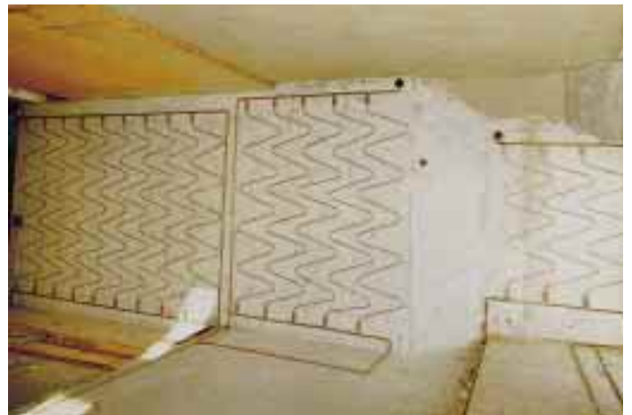
Fertig montierte Wandflächenheizung von Sera
