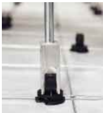
Die Rehau-Drehclips lassen sich im Stehen setzen und arretieren
