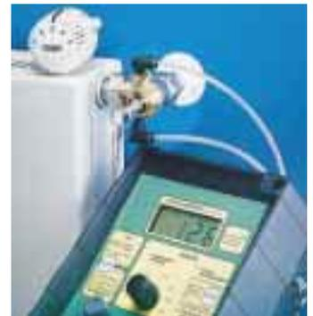
Thermostat-Ventilunterteil „VarioQ“ mit stufenloser Voreinstellung und Meßblende für Meßgerät System „Quitus“ (Gampper)
