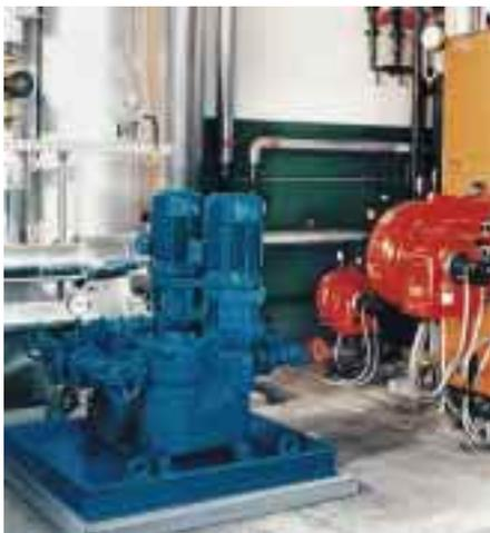
Zubringer-/Transfer-Pumpenaggregate für die Heizölversorgung von Allweiler
