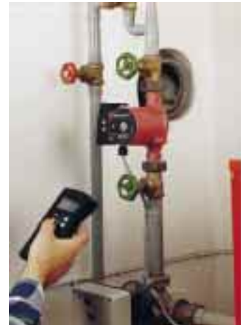
Nur mit der Fernbedienung R 50 oder R 100 läßt sich die UPE 25-40 Profi richtig in Betrieb nehmen
