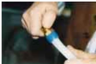
**Wirsbos neue Generation der PEX-Rohr-Verbindung: Q & E-Ring aufs Rohrende schieben und aufweiten, Fitting ins Rohrende stecken, Schrumpfen lassen**
