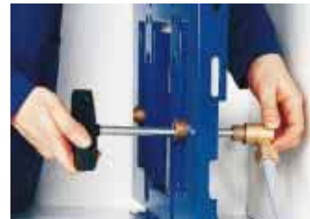
Für die Befestigung der Wasseranschlußwinkel in Vorwandinstallationselementen entwickelte Aquatherm das Sanquick-System
