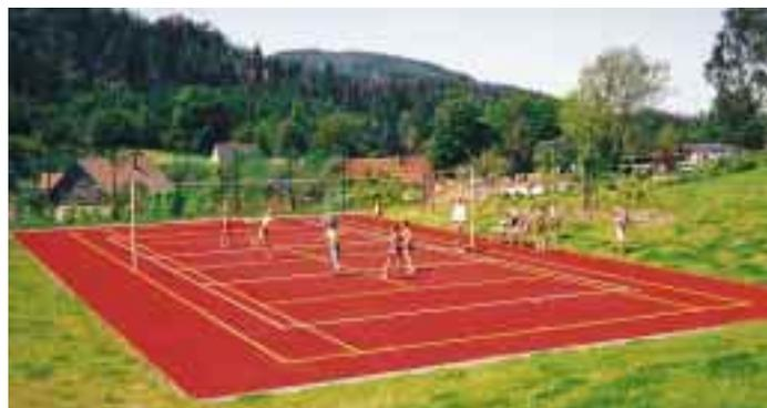
eines Ballspielplatzes oder einer Schwimmbeckenumrandung gleichzeitig als Absorber für die Beheizung eines Schwimmbades im Sommer oder einer Kunsteisfläche im Winter dienen wie auch als Absorber einer Wärmepumpe für Raumheizung und Wassererwärmung. Der Belag besteht aus einem EPDM-Solarabsorber, der in eine 25 mm dicke Schicht aus verklebtem EPDM-Granulat eingebettet ist. Er kann in ver-
